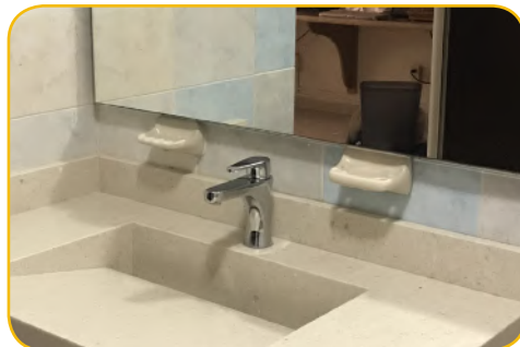
Remodelación de 4 baños en planta baja
