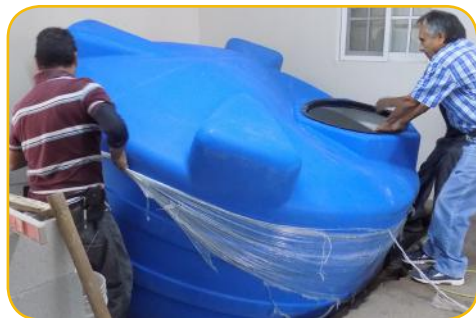
Instalación de cisterna
