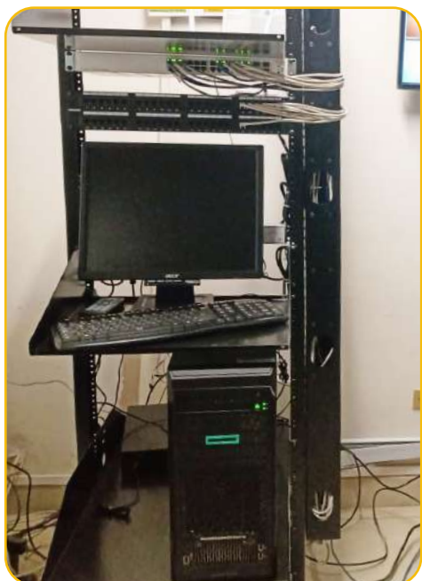
Instalación de redes internas y servidor
