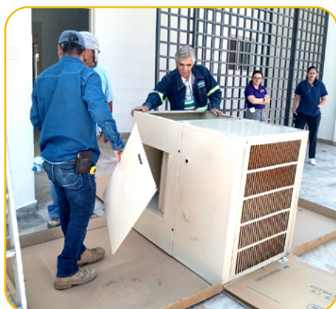
Instalación de aparatos de aire lavado y acondicionado. "Alas Creativas"
