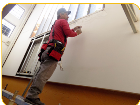
Reparación de techos y paredes de nuestra casa.
